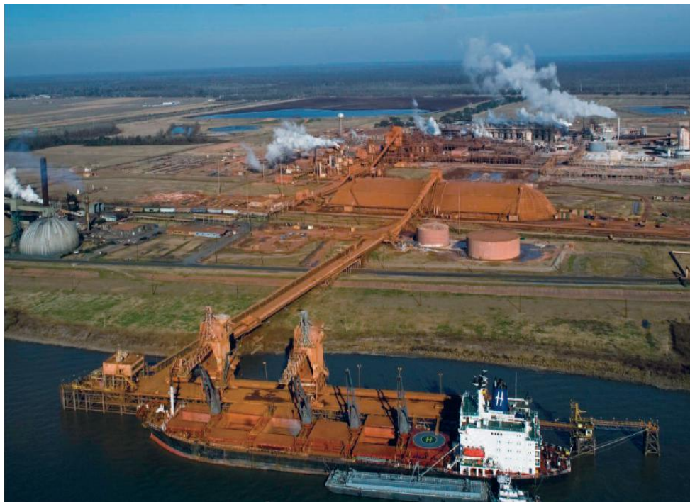
诺兰达氧化铝厂及卸港码头
